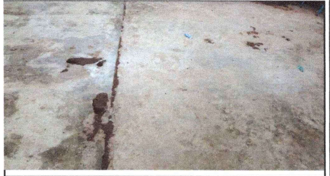
Foto 2: Mantenimiento de piso de corredor
