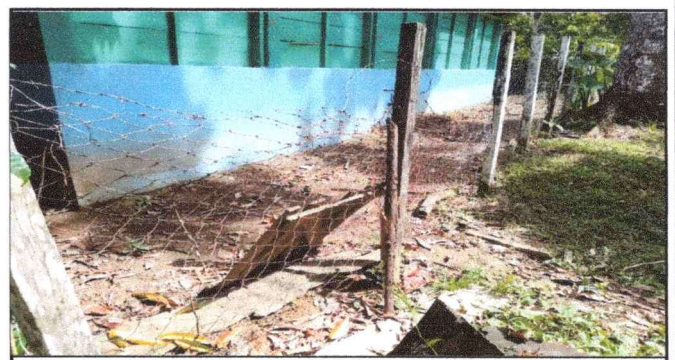
Foto 6: Sustitucion de malla perimetral en mal estado
