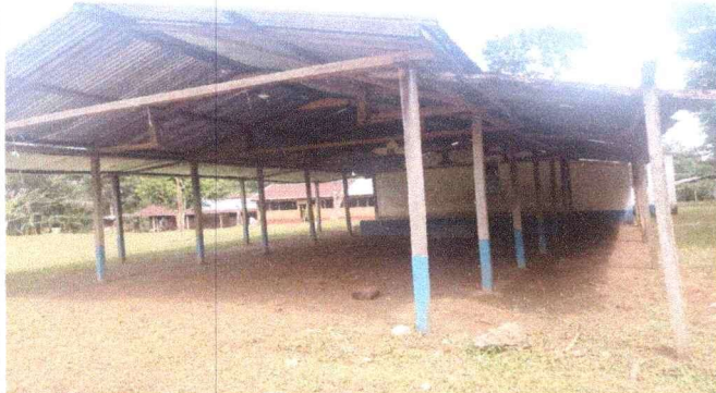
Foto 3: Sustitucion de base madera a columna de concreto
