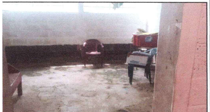
Foto 4: Sustitucion de piso de aula
